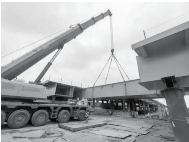
图 11 钢箱梁吊装
