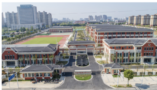
福地路小学新建工程 （全国建设工程项目施工安全标准化项目）
