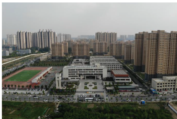
里巷口小学工程（扬子杯）
