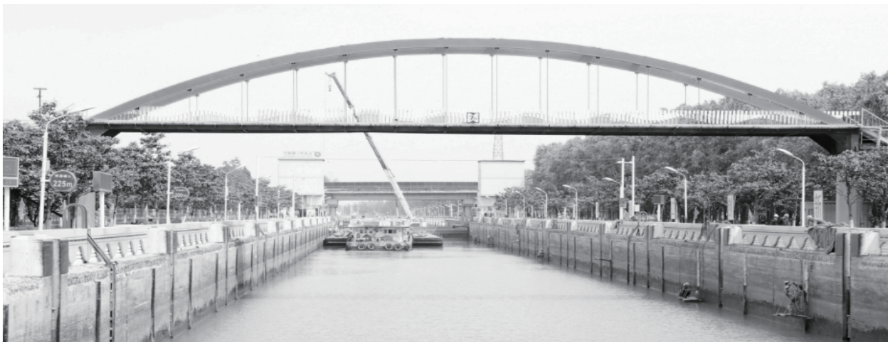
大修船闸实景（基层单位 供图）
